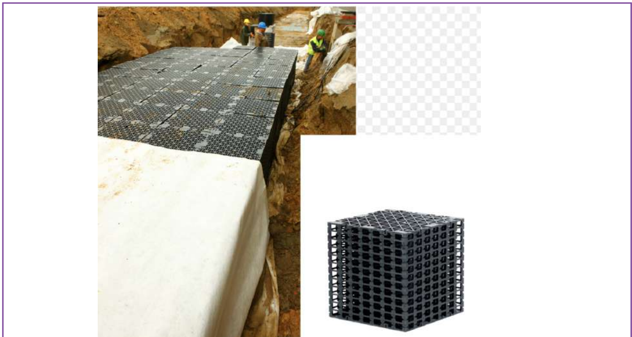
FIGURE 7 : EXEMPLE DE CAISSON DE STOCKAGE ET D'INFILTRATION
